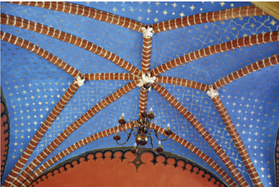
55. Czerna, dwór, sklepienie w pomieszczeniu południowo-wschodnim przyziemia
