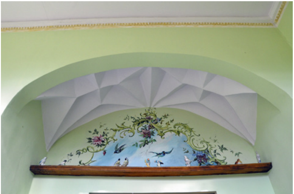
57. Czerna, dwór, sklepienie niszy pomieszczenia południowego
