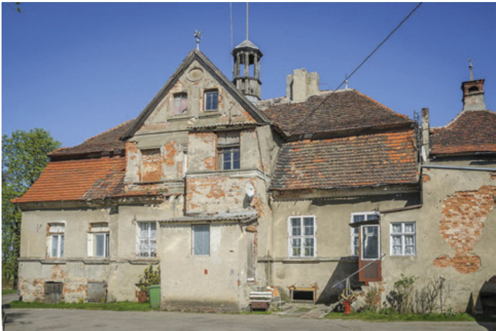
83. Kamiona, dwór, widok od zachodu
