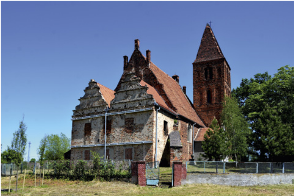
148. Żukowice, kościół pod wezwaniem św. Jadwigi, widok od południowego zachodu
