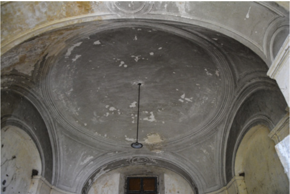
143. Szczepów, pałac, widok sklepienia kaplicy w budynku bramnym
