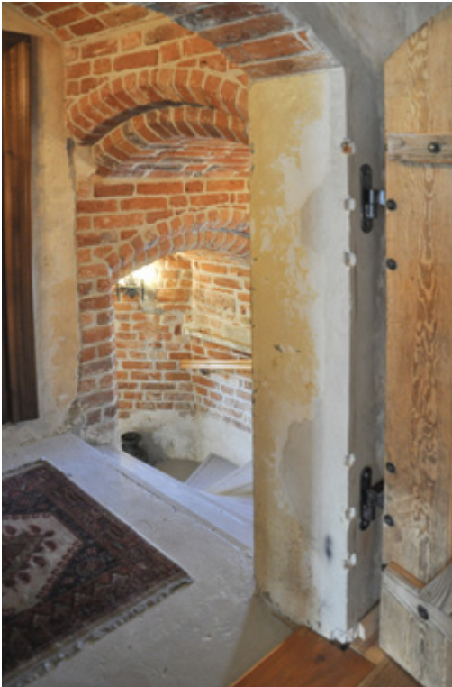
51. Czerna, dwór, klatka schodowa w wieży
