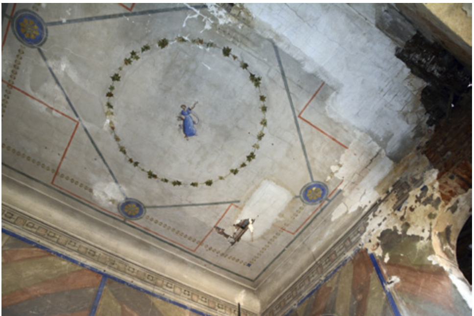
27. Brzeg Głogowski, pałac, malowidła na piętrze
