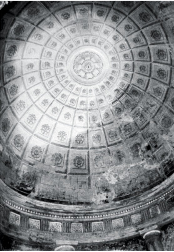
19. Szczepów, mauzoleum rodowe von Schlabrendorfów, widok kopuły w 1982 r.
