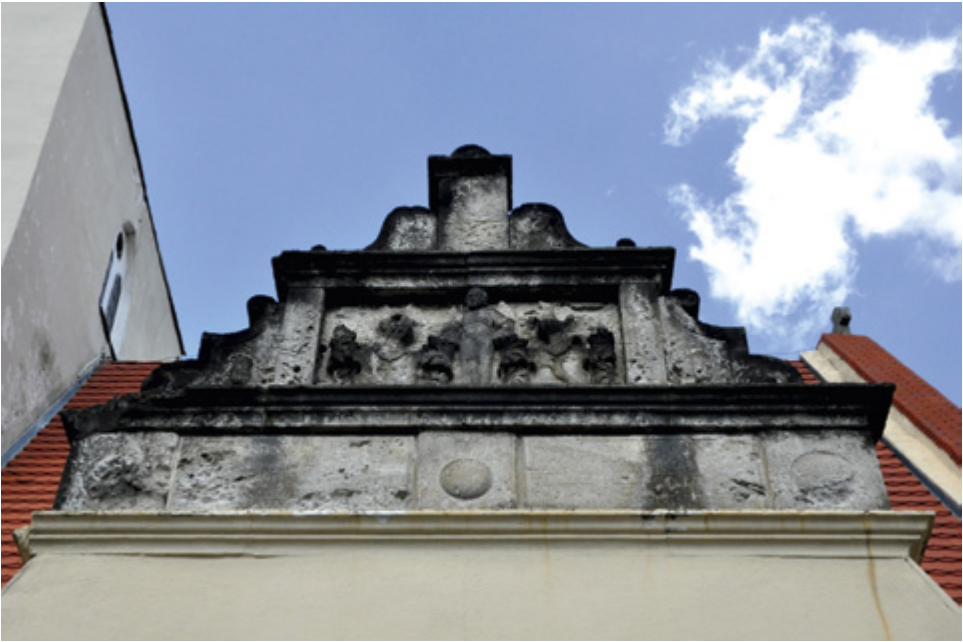
104. Kromolin, kościół pod wezwaniem św. Michała Archanioła, szczyt kruchty południowej
