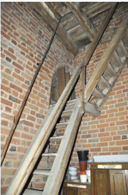
149. Żukowice, kościół pod wezwaniem św. Jadwigi, widok wnętrza wieży
