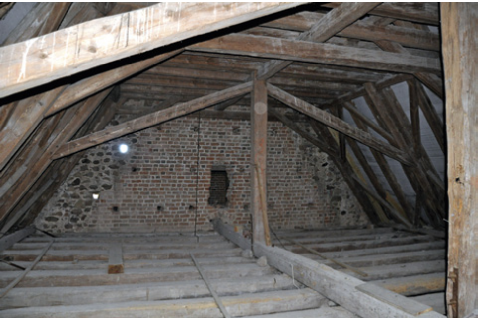
125. Nielubia, kościół pod wezwaniem św. Michała Archanioła, widok poddasza
