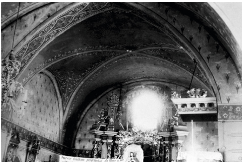
22. Żukowice, kościół pod wezwaniem św. Jadwigi, widok sklepienia i ścian prezbiterium w 1958 r.
