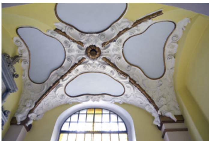
18. Brzeg Głogowski, kościół parafialny pod wezwaniem Bożego Ciała, dekoracje stiukowe na sklepieniu kaplicy południowej
