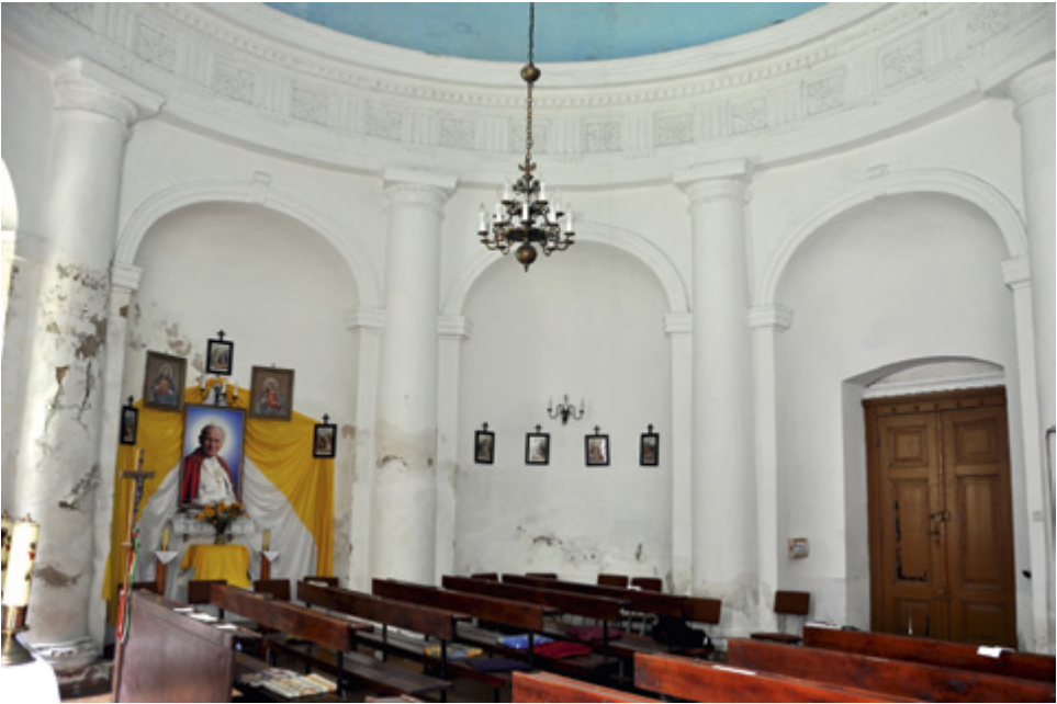
146. Szczepów, kaplica grobowa Schlabrendorfów, ob. pod wezwaniem Jezusa Miłosiernego, widok wnętrza w stronę północną
