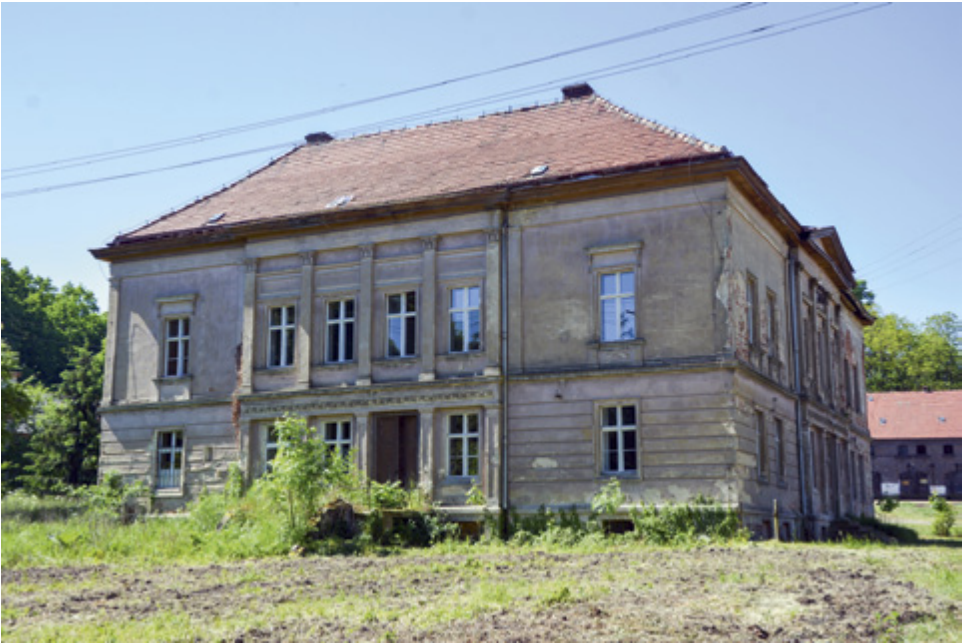
67. Dankowice, pałac, widok elewacji północno-wschodniej
