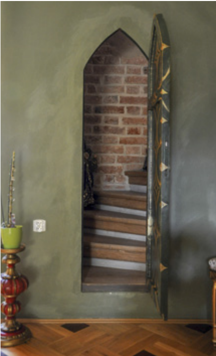
53. Czerna, dwór, schody w grubości muru południowego
