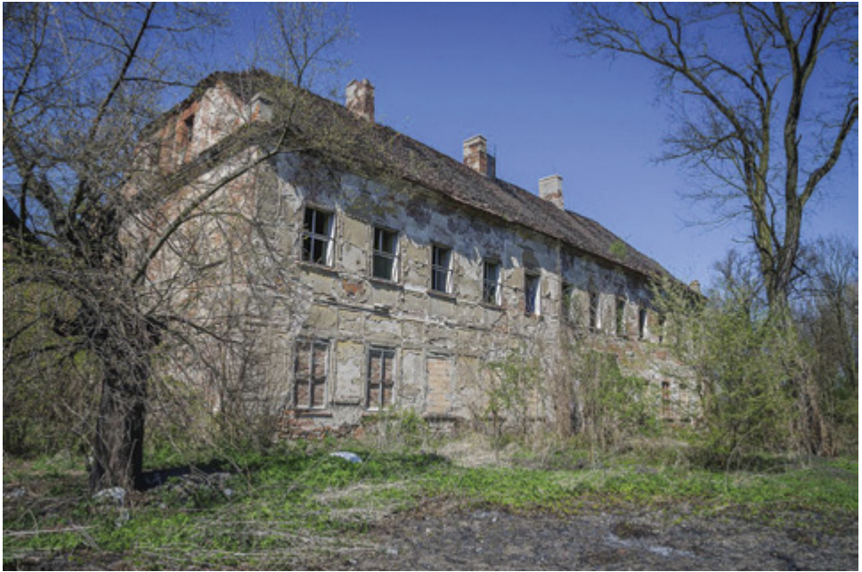
26. Brzeg Głogowski, pałac, elewacja wschodnia
