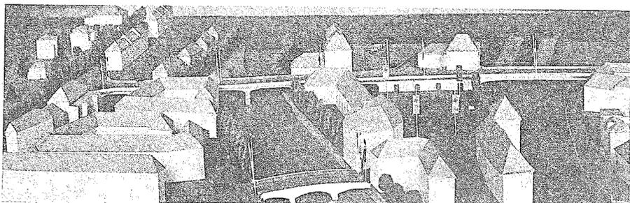
Die neue Straßenbrücke verbindet in einem Zuge die beiden Reichsstraßen nach Schneeberg und nach Chemnitz über die Mulde, die neuen Bahnhoftanlagen und zwei Nebenstraßen hinweg. Bestehende Höhenunterschiede im Gelände sind für die Lösung der Aufgabe gut ausgenützt. Die Modellaufnahme zeigt rechts im Hintergrund die neue Bahnhoftanlage, daneben den Brückenteil über die Mulde und links die Einmündung in die Reichsstraße nach Schneeberg. Im Vordergrund liegt die Schillerbrücke über die Mulde.
