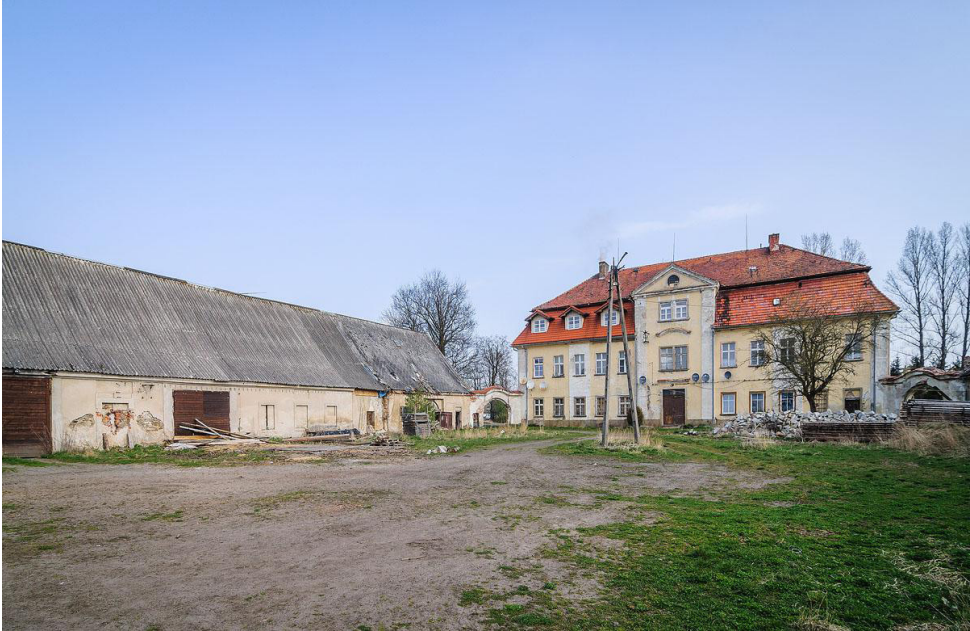
Fot. 93. Miskowice, dawny pałac (nr 85) oraz budynek gospodarczy, widok od południowego wschodu
