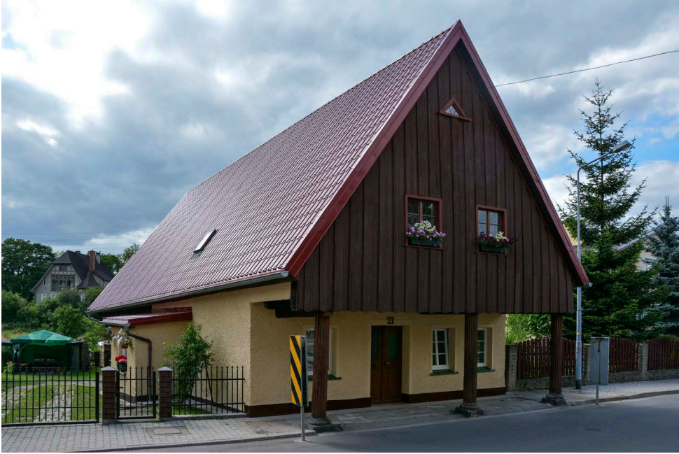
Fot. 87. Chełmsko Śląskie, ul. Kamiennogórska 21, widok od południowego wschodu
