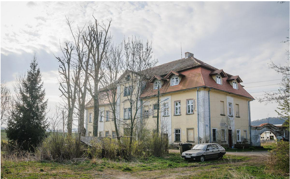
Fot. 92. Miskowice, dawny pałac (nr 85), widok od północnego zachodu
