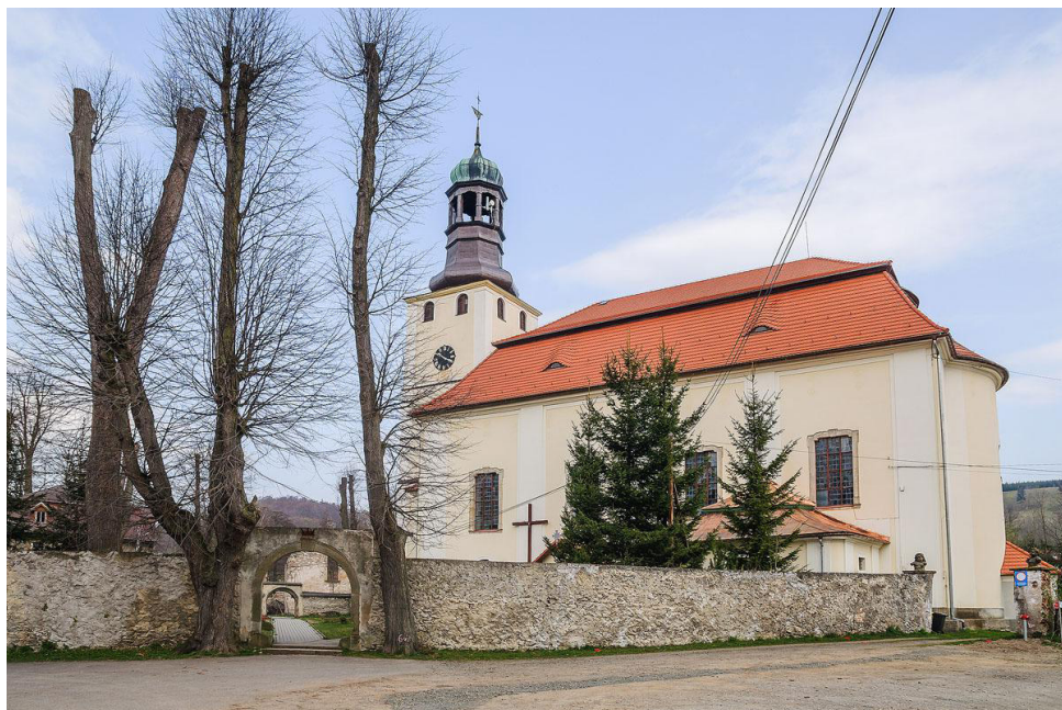
Fot. 63. Kościół pod wezwaniem Wszystkich Świętych w Miszkowicach, widok od południowego zachodu
