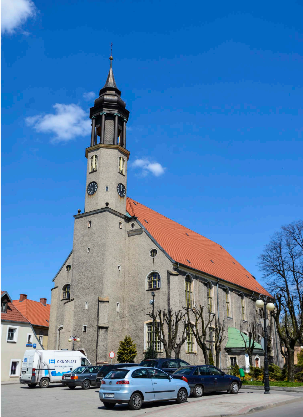
Fot. 67. Kościół pod wezwaniem Wniebowzięcia Najświętszej Marii Panny w Lubawce, widok od południowego zachodu
