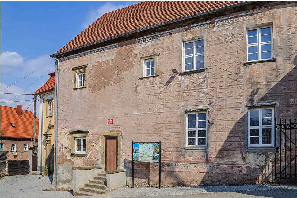
Fot. 34. Budynek starej plebanii pokryty dekoracją sgraffitową w Chełmsku Śląskim, widok od zachodu
