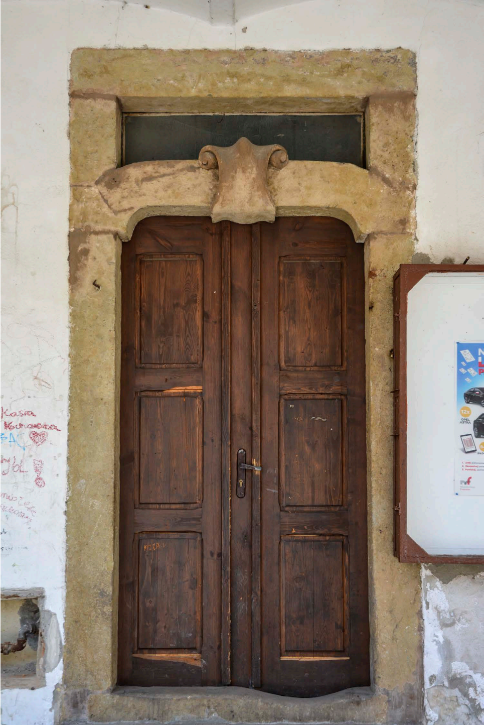
Fot. 16. Lubawka, pl. Wolności 9, portal, widok od wschodu
