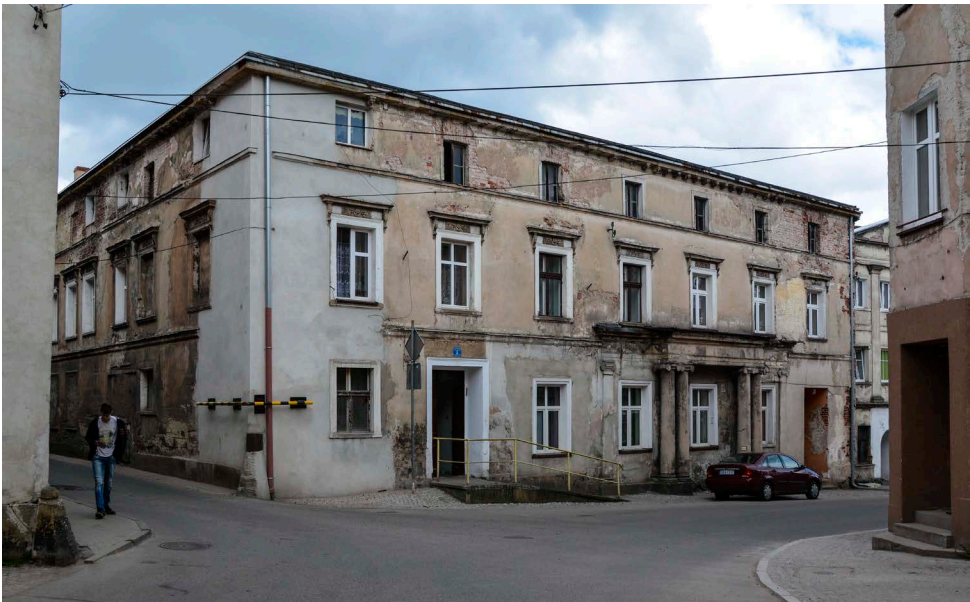
Fot. 83. Chełmsko Śląskie, ul. Kamiennogórska 5, widok od południowego wschodu
