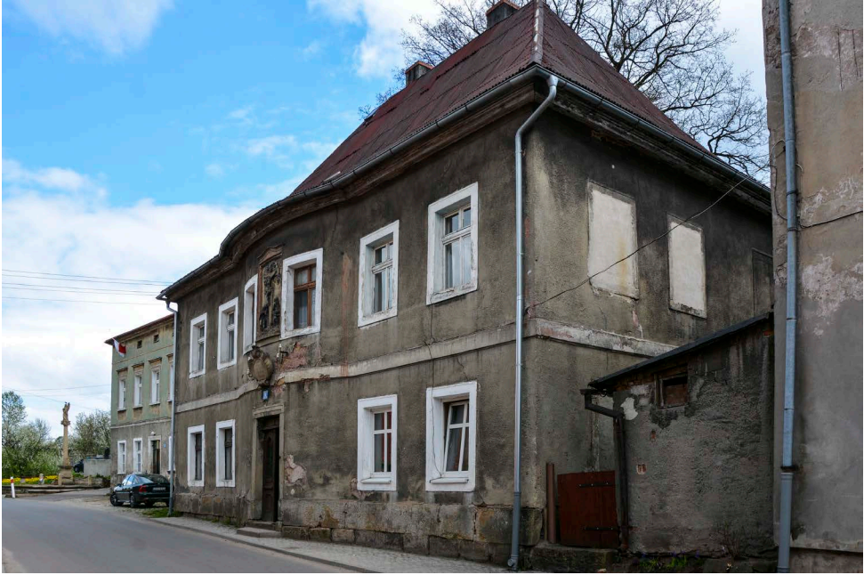
Fot. 4. Chełmsko Śląskie, ul. Kamiennogórska 18, widok od południowego zachodu
