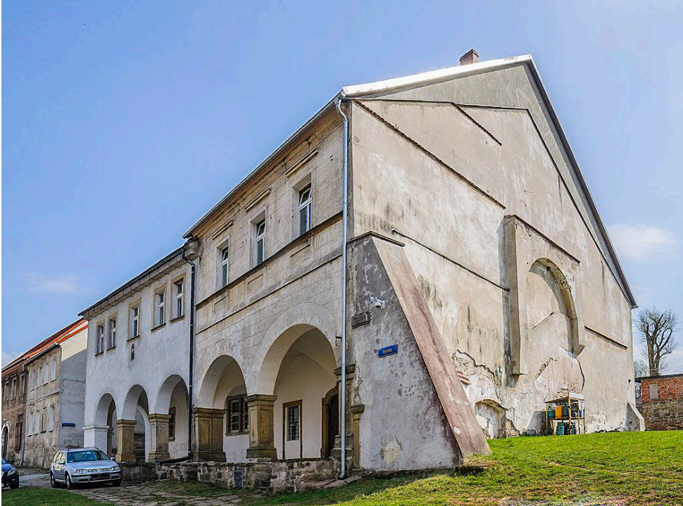
Fot. 82. Chełmsko Śląskie, Rynek 21–22, widok od północnego zachodu
