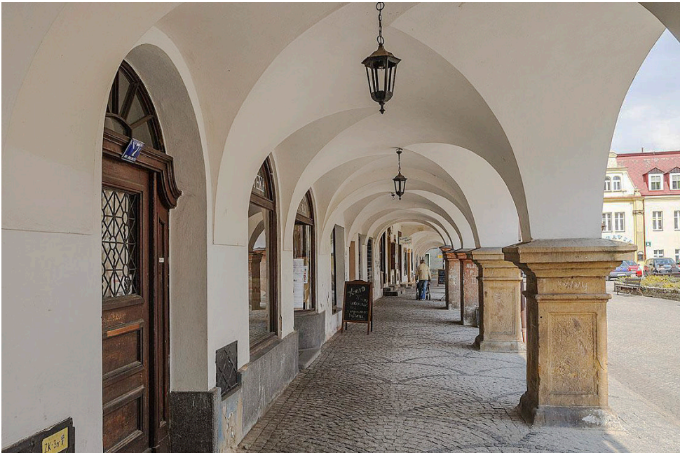
Fot. 13. Lubawka, pl. Wolności, podcienia kamienic pierzei zachodniej, widok od południa
