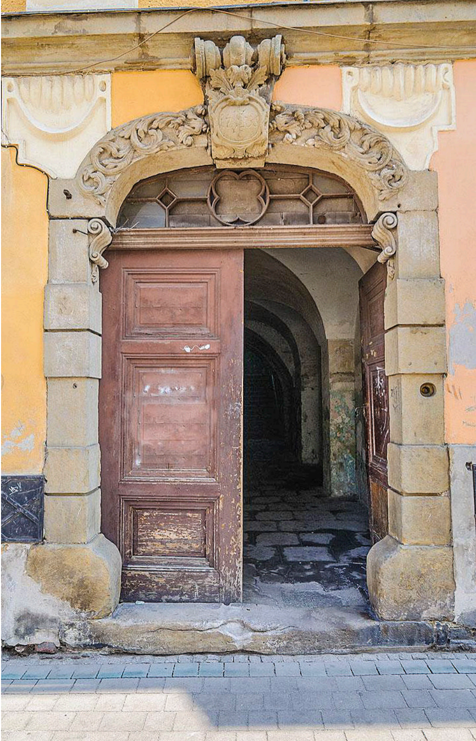
Fot. 9. Lubawka, pl. Wolności 20, portal w przyziemiu fasady, widok od zachodu
