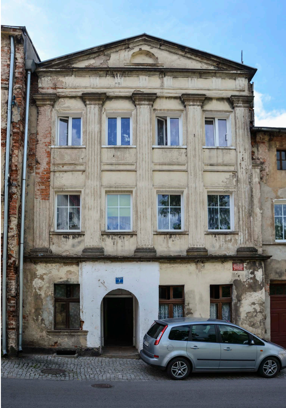
Fot. 84. Chełmsko Śląskie, ul. Kamiennogórska 7, widok od południowego wschodu
